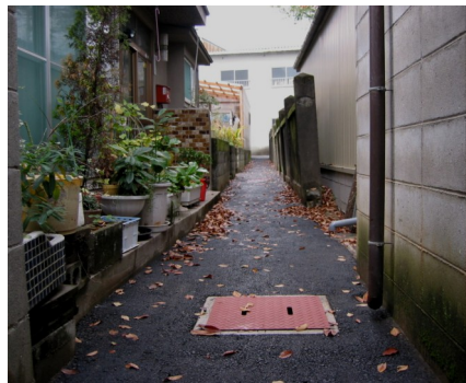
改修後は集水マスの段差も無くなり舗装されて通行がより安全になった
