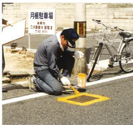
消火栓に黄色の即乾性塗料を塗る 第5部消防団員 六月一日
