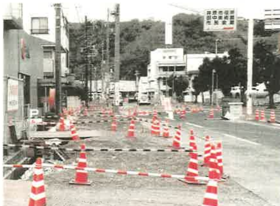
4 mに広がる歩道の拡張工事=1月26日撮影
