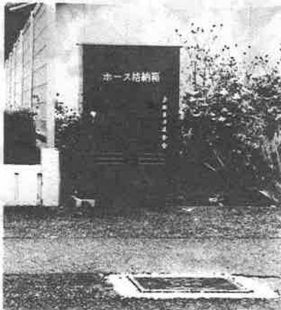
器具箱の手前に消火栓の蓋が見える
