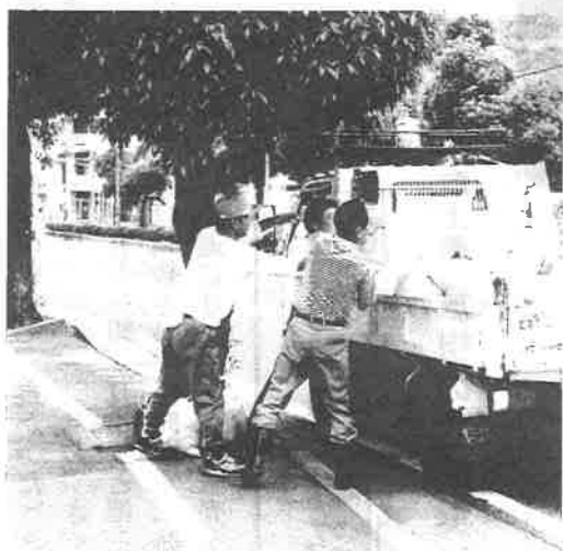
地域をあげての溝掃除は、最も大切な自治会活動の一つ。写真は駅前大通りで土砂の入った土のう袋を積み込む連合会役員＝倉掛地区15-2組のトマト銀行前
