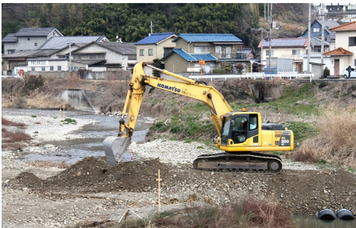
倉掛裏(大正橋～井原大橋間)の小田川河川敷に堆積した土砂を取り除く河道掘削工事が2月上旬から始まっている。工期完了は3月31日予定。
