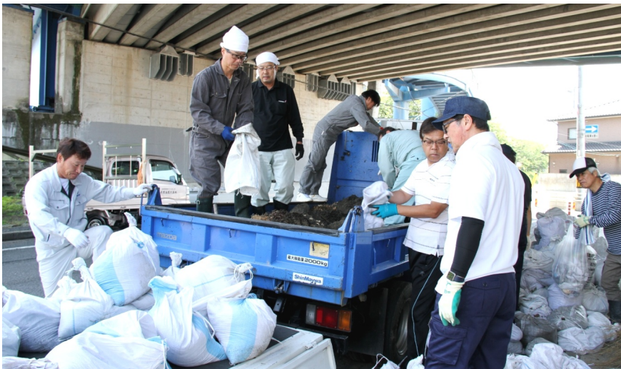
土のう袋から土砂を取り出す作業に追われる役員＝井原大橋下
