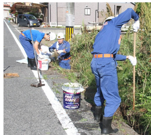
深い側溝の清掃作業＝倉掛公園北側
